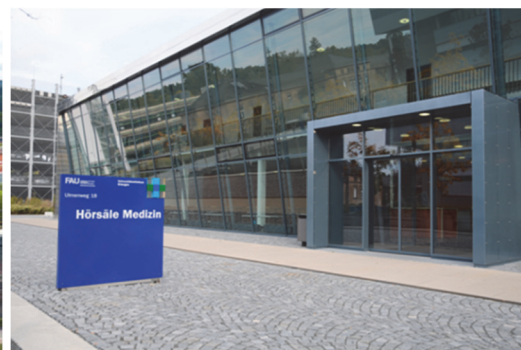
Hörsaalzentrum (HSZ), Ulmenweg
